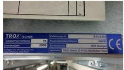
*Analog zu den Brandschutztüren unterscheidet man bei den Brandschutzklappen ebenso die Feuerschutzklassen von K30 (feuerhemmend) über K60 (hoch feuerhemmend) und K90 (feuerbeständig).*
