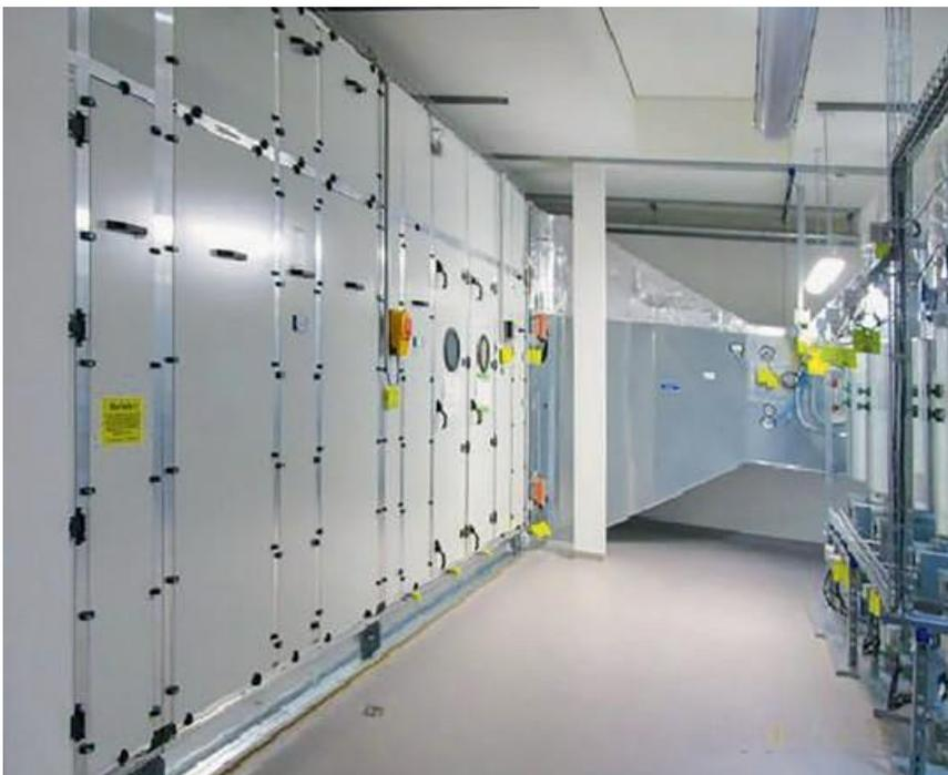
*Wichtigstes Element der Lüftungsanlage sind die Luftfilter, die im Rahmen der Wartung geprüft und gereinigt bzw. getauscht werden. Stimmt die Qualität nicht mit der geforderten überein oder ist die Verschmutzung zu gravierend, sind diese zu tauschen.*
